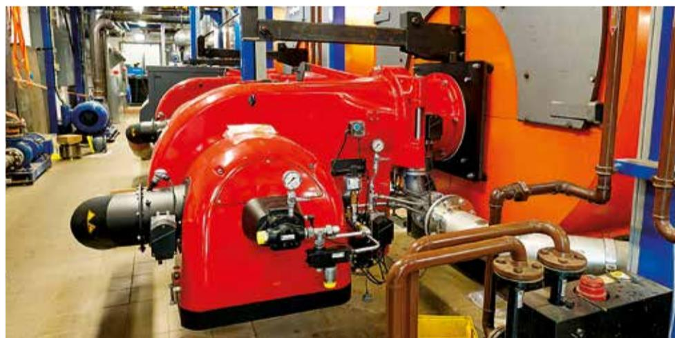
Die neuen Brenner wurden an den Heizkesseln montiert.
