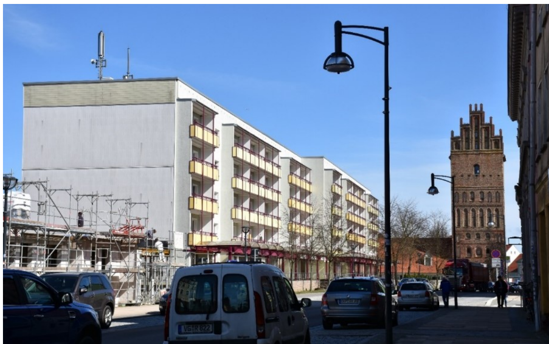
Abb. Standort im Zustand vor dem Abriss. (Die Liegenschaft wird im berühmten Zustand veräußert!)
